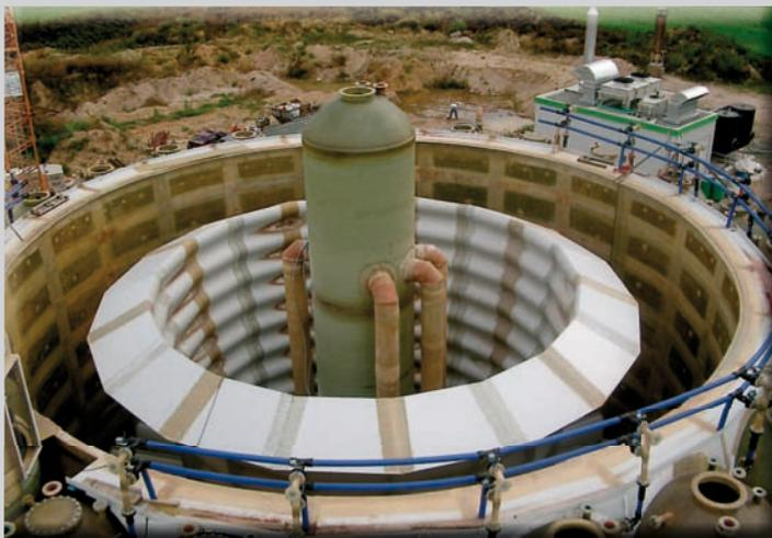
*Epoflex wurde hier an den Innenwänden montiert, um die dahinter liegende Betonwand vor der aggressiven Gülle zu schützen!*
